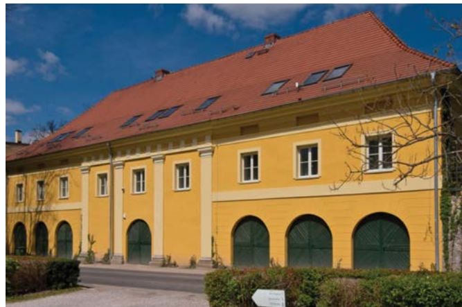
Gesellschaftshaus Buchwald nach der Renovierung Bukowiec po renowacji (Foto Klaus-Henning von Krosigk)
