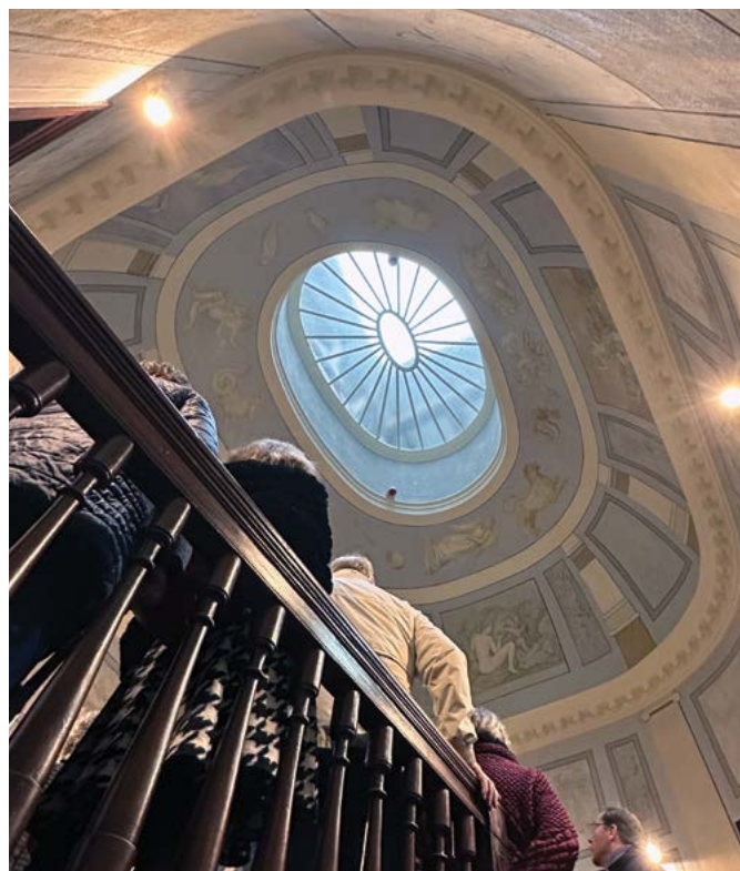
Schloss Buchwald – historische Lichtkuppel (Foto Joachim Stenke) Pałac Bukowiec – historyczna kopuła świetlna
