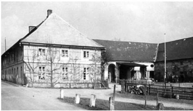
Wirtschaftsgebäude Schloss Buchwald (Foto Günther Grundmann, Gutachten über Buchwald 1938) Budynki gospodarcze pałacu Buchwald 1938 r.
