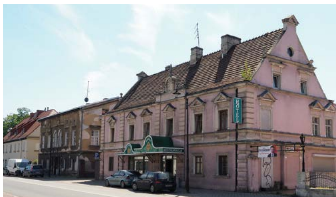
Ehemaliges Brüdergemeine-Gasthaus, links Wohnhäuser, 2025 Dawna gospoda wspólnoty braci morawskich, po lewej stronie budynki mieszkalne
