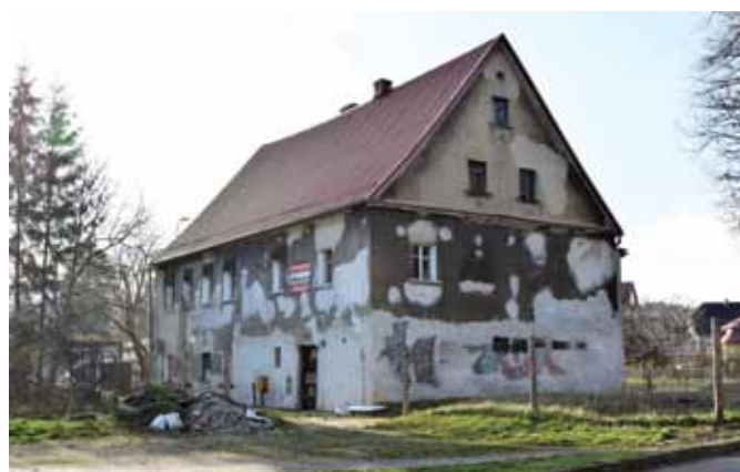
Alte Bleiche am Zacken Stara bielarnia nad rzeką Kamienną
