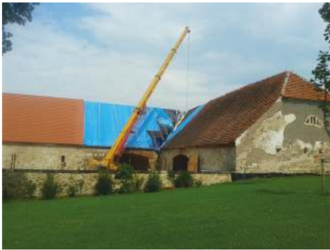
Guttscheune Schloß Lomnitz während der Renovierung Stodoła Folwarczna Pałacu Łomnica podczas remontu
