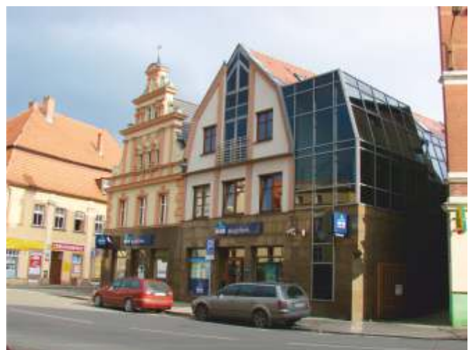
Hirschberg, Kredit Bank – gelungenes Beispiel für Sanierung Jelenia Góra, Kredyt Bank – udany przykład rewitalizacji
