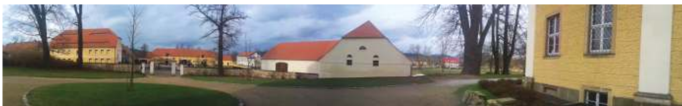
Gutsscheune Schloß Lomnitz nach der Renovierung Stodoła Folwarczna Pałacu Łomnica po zakończeniu remontu
