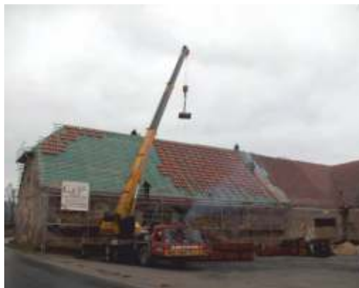
Eindeckung der Scheune |
